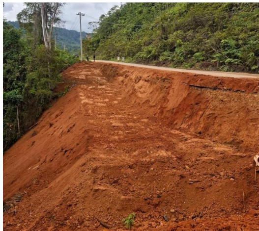
Gambar 2. Platform Pekerjaan Borepile Sumber : Foto Dokumentasi
