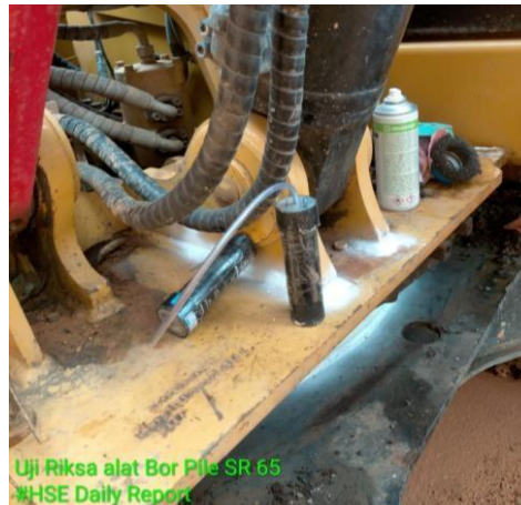
Gambar 4. Proses Uji Riksa Alat Drilling Rig Sumber: Foto Dokumentasi
